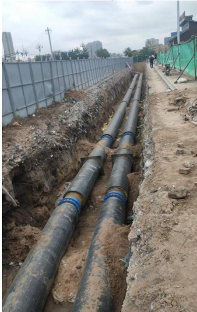
刘沙公路管腔周围砂回填夯实
