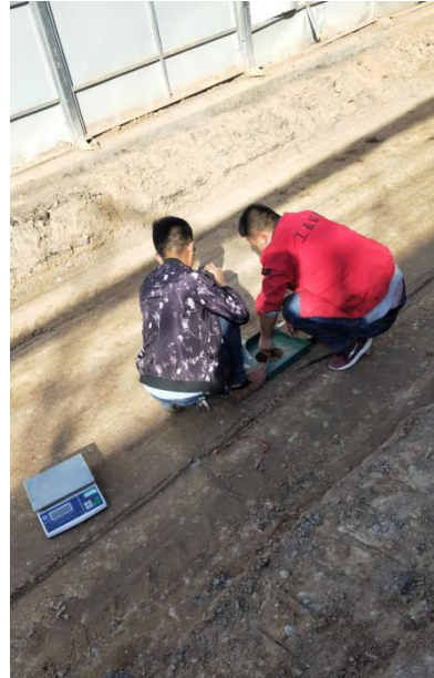
刘沙公路管道试压
